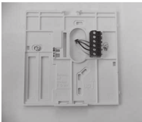
Fixer les câbles à la plaque à bornes
